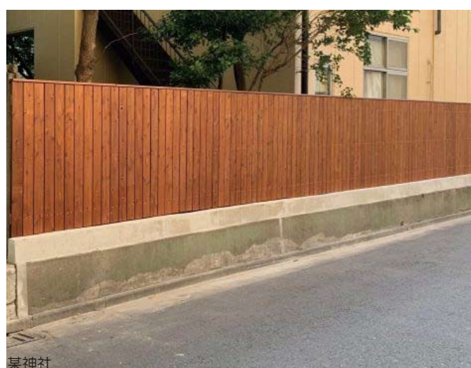
某神社 商品仕様/ObiRED テッキ材 4000*90*20 (フェンス縦板) 現地塗装
